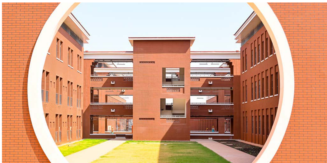
Vue du nouveau CHU de Pala à Bobo-Dioulasso.
