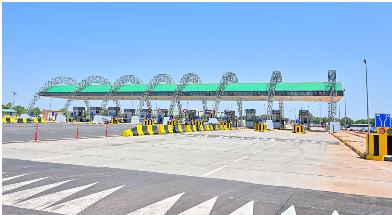
Vue du poste de péage moderne à la sortie Ouest de Ouagadougou, conçu pour fluidifier le trafic, renforcer la sécurité routière et améliorer les services aux usagers.
